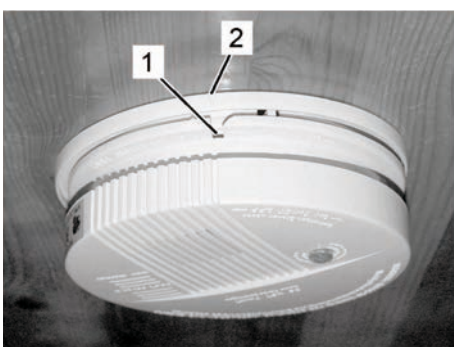
Kuva 163: Rungon kiinnitys paikoilleen
