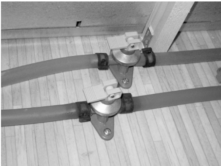
Abb. 160: Ablassventile geschlossen
