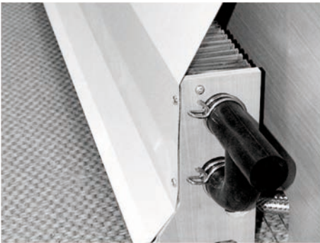
Abb. 85: Konvektor mit Wärmeleitblech
