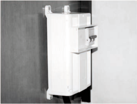
Abb. 3: Hauptschalter (FI-Schutzschalter)
