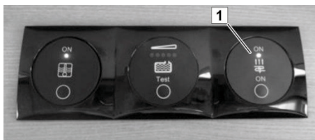
Abb. 130: Ein-/Aus-Schalter der Fußbodentemperierung
