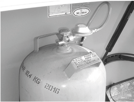
Abb. 70: Gasflasche mit Niederdruckregler und Niederdruckschlauch
