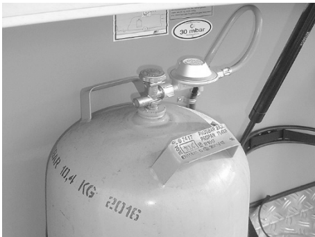
Abb. 108: Gasflasche mit Druckminderventil
