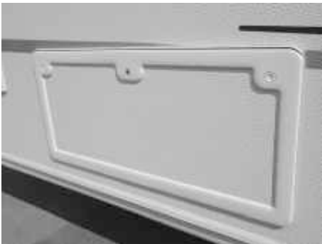
Abb. 19: Wohnaufbau, Servicefach außen
