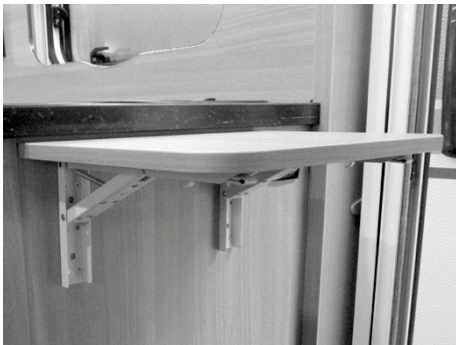
Abb. 205: Klappkonsole zur Verlängerung der Küchenarbeitsplatte
